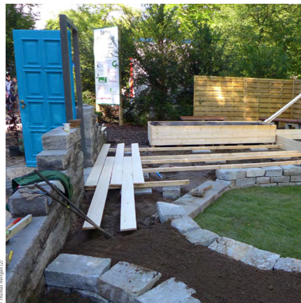
Auf der Lehrbaustelle entstand innerhalb von drei Tagen ein ansehnlicher Wohngarten, unter anderem mit Natursteinmauern, Terrasse, Wasser und Rasen.
