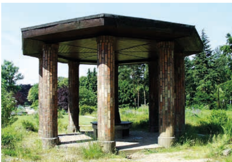
Pavillon im Altonaer Schulgarten vor der Sanierung
