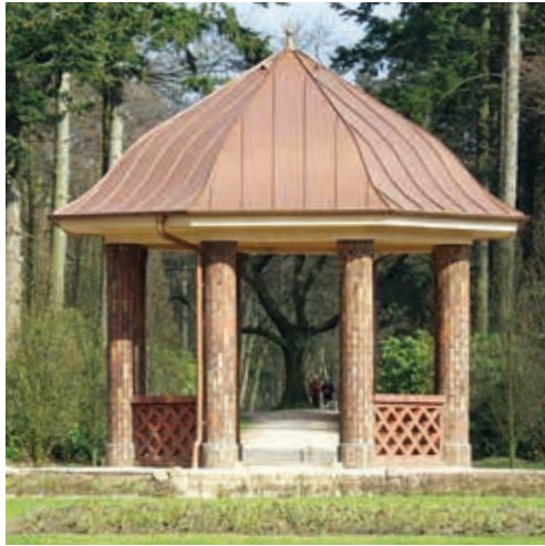
Pavillon Altonaer Schulgarten nach Sanierung
